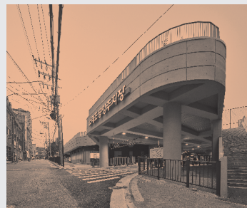
상 학교복합시설 입구진입마당 하 지하주차장 입구와 운동장으로 이어진 등교계단
