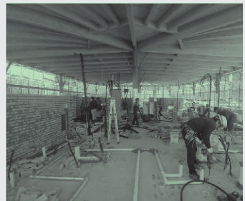
상 목구조 시공 모습 중 지붕 널 시공 모습 하 내부 조적벽 시공 모습
