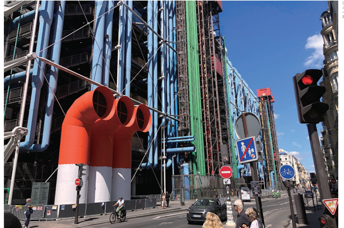
풍피두 센터와 외부로 노출된 색색의 설비 파이프
