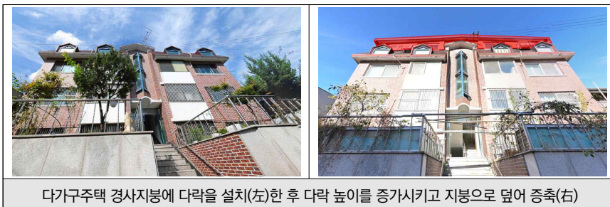
[그림 2-14] 다가구주택에 다락을 불법 증축하여 위반건축물로 적발된 사례
