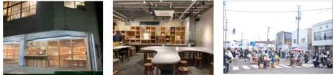
마루히코빌딩 정비 후
