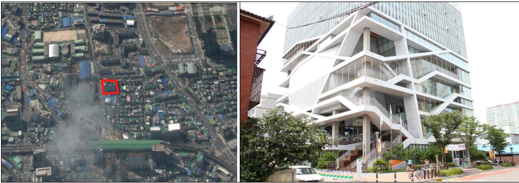
[그림 3-5] 대상지 입지 현황 및 전경(성수 문화복지회관)
