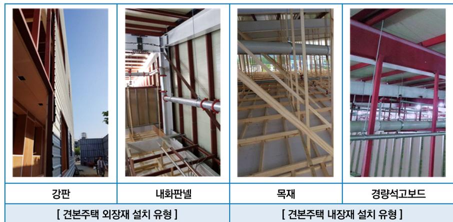
[그림 3-7] 건본주택의 외장재 및 내장재 설치 유형
