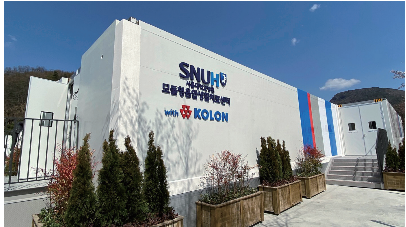
생활치료센터의 모듈형 음압병실 필요한 곳에 이동하여 간편하게 설치, 운용이 가능하다.
