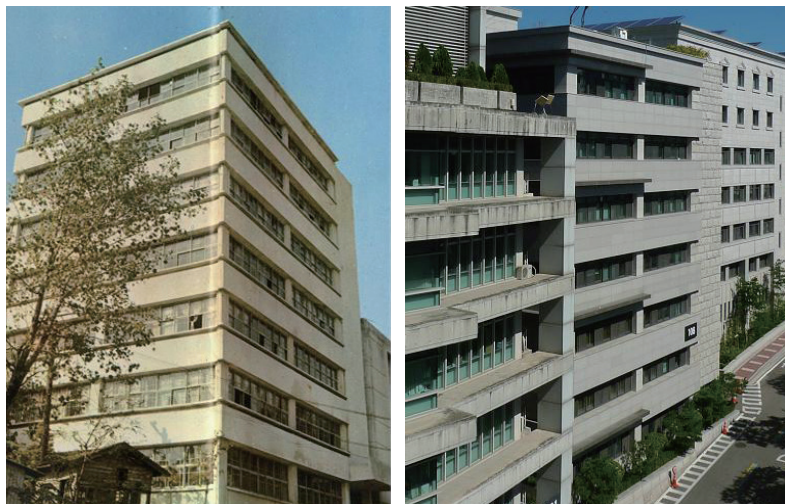
건축(공)학부 도서관이 있던 토건관의 1970년대 모습(좌), 리모델링 후 2018년의 모습(우)
