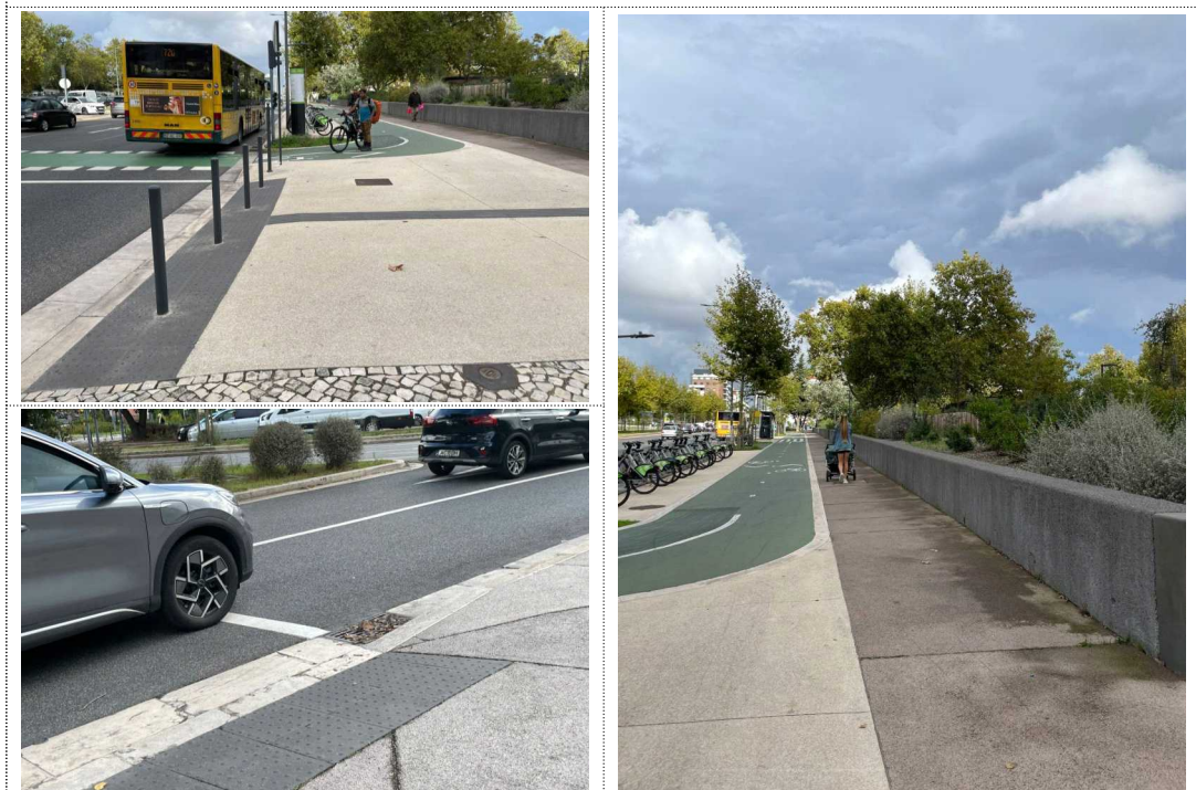
보도와 도로 간 경계부 평탄화를 통해 노약자와 휠체어 이용자의 이동 편의성을 높임. 자전거와 보도의 동행 체계 분리를 통해 보도 통행 시 보행자의 안전성을 확보하고, 교차로 내 이용자(보행자와 자전거 이용자) 간 발생할 수 있는 상충 작용을 완화할 수 있게 조성됨
