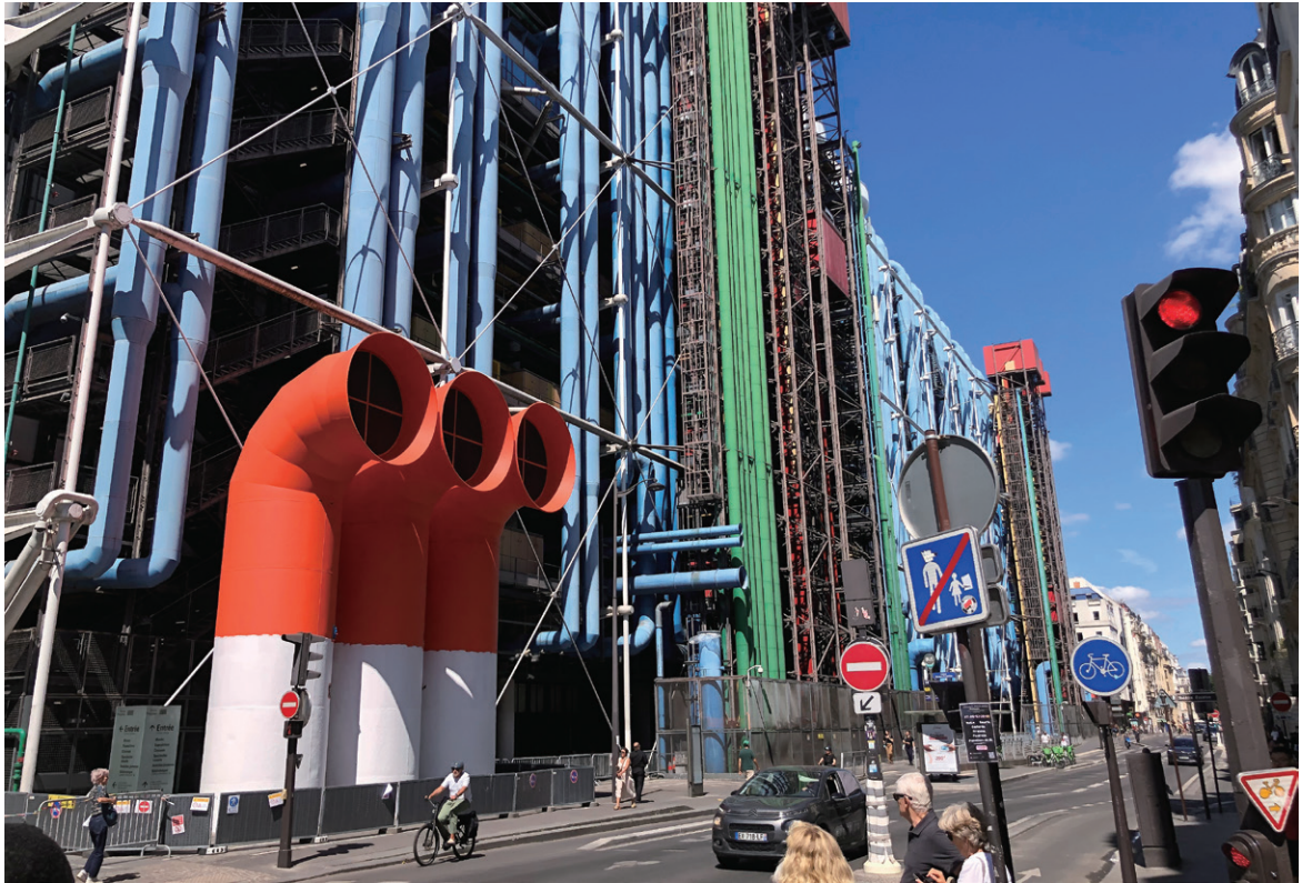
퐁피두 센터와 외부로 노출된 색색의 설비 파이프
