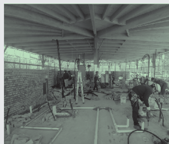
상 목구조 시공 모습 중 지붕 널 시공 모습 하 내부 조적벽 시공 모습
