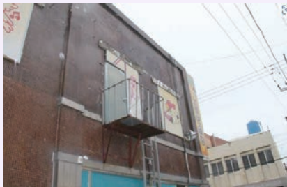
발코니형 비상구 설치 사진
