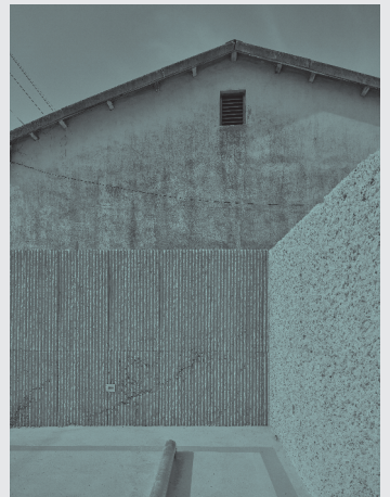
상 1층 주민공동시설 중 2층 주민공동시설 하 담장과 박공지붕의 창고
