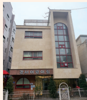
서울시 강서구 강서어린이집 보강 후
