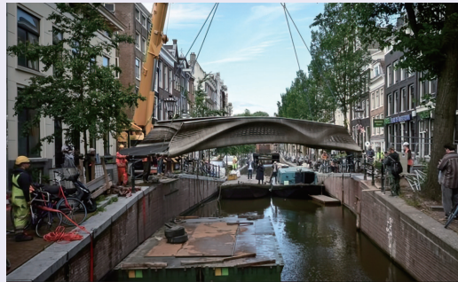
네덜란드 막시마(Máxima) 여왕이 참석한 강철 스마트 다리의 개통식 출처: 암스테르담시 홈페이지. https://www.amsterdam.nl/en/news/3d-printed-bridge-opens-amsterdam/ (검색일 : 2021.9.6.)
