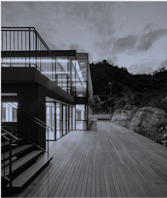
상 전면유리로 개방성을 높인 모습 중 2층 동측 전경 하 2층 외부데크에서 바라본 초소책방
