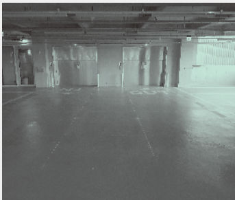
상 1층 카리프트 자주식 주차 출입구 중 5층 주차장 실내 하 5층 카리프트 자주식 주차 출입구
